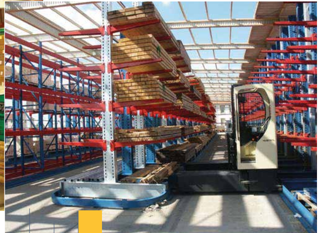
Installation eines selbsttragenden Gebäudes mit Führungsschiene am Boden für die Flurförderfahrzeuge
